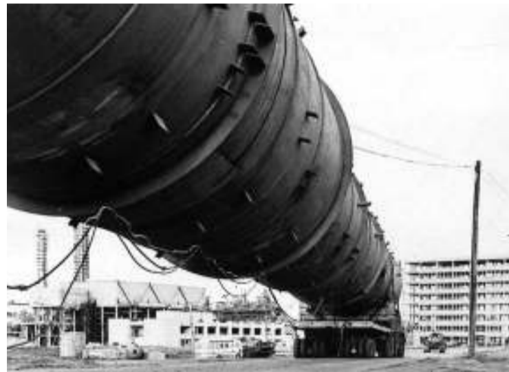
1979 год. Продолжается доставка крупногабаритного оборудования для будущих производств
